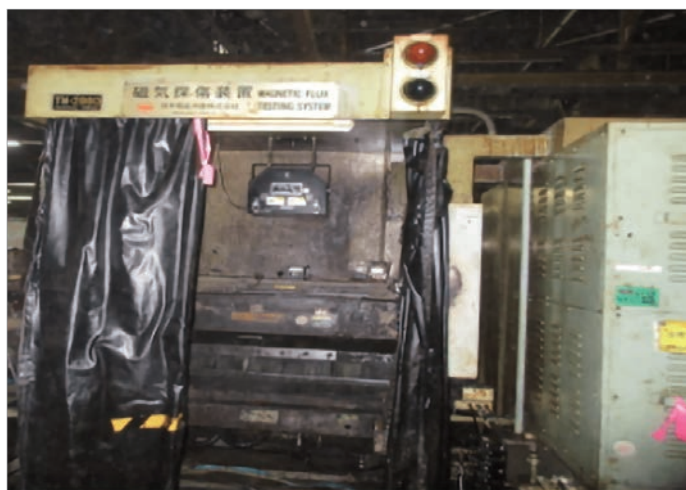
改造前磁気探傷装置
